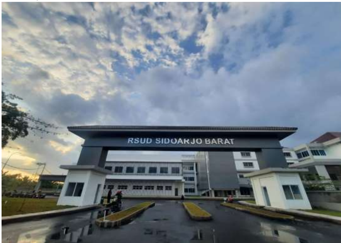
Gambar 2.1 RSUD Sidoarjo Barat Tampak Depan
