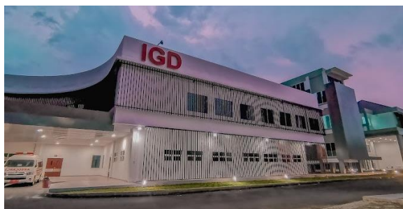
Gambar 2.2 Tampak depan Instalasi Gawat Darurat
